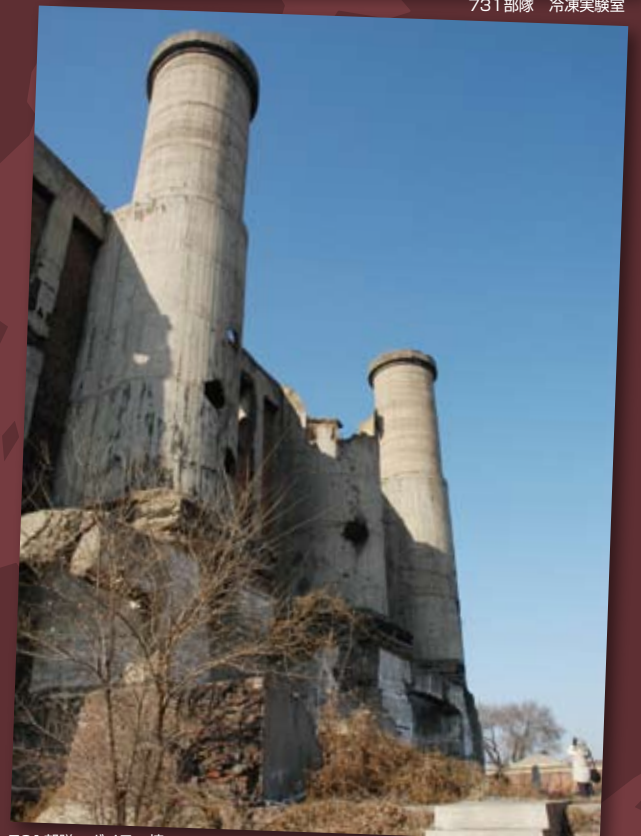
731部隊 ボイラー棟
